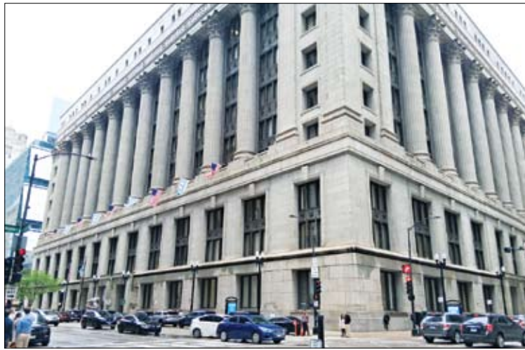
City Hall, 121 N. LaSalle St.
